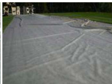
application of DuPont™ Typar® geosynthetic on the football field グラウンドに拡げた状態
