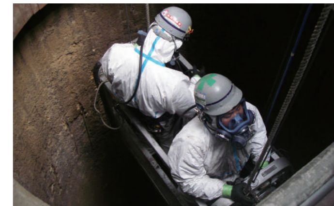
ダイオキシン含有灰の掻き落とし作業
