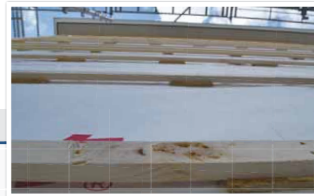
横胴縁でも通気を確保するために9mm厚の木片を施工
