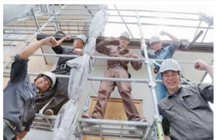
実物大の模擬棟で施工を一通り行う。
