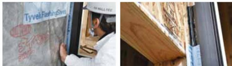
別の部位では、開口部同士が隣接している箇所があった。ここでは、プチルテープを入隅部分へ丁寧に施工し、その上から水切りシートで補強した。これで完全に雨水浸入を防ぐことができる。サッシをはめ込んだ後は、防水施工が出来ない部位となるため、事前に注意したい箇所である。
