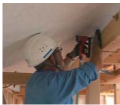
④ 仮留めが終わったら、タッカーなどで母屋や垂木に本留めしていきます。
