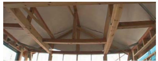
⑦ 施工完了です。
