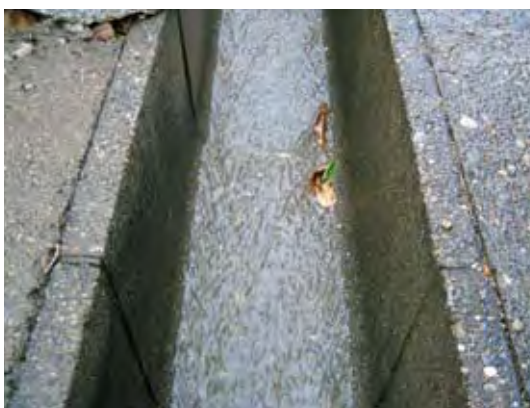
●側溝への排水
