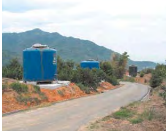
灌水施設(予備タンク、チューブ類)の設置(香川県)
